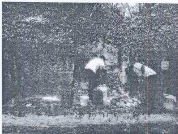
Foto 8. Aplicación de refuerzo con embono al elemento localizado al Norte del Patio 4, Acrópolis Sur
